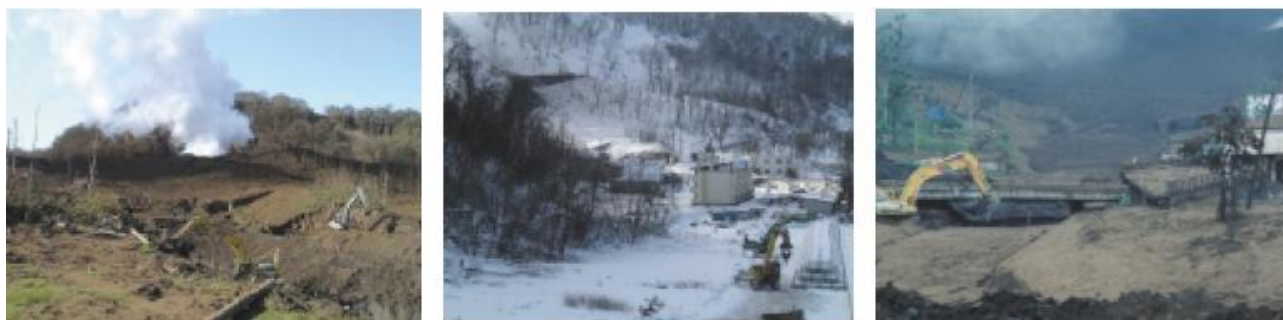
Trabajos de Restauración en Monte Usu bajo Control Remoto
